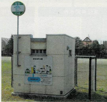
【写真】緊急貯水槽の上屋
