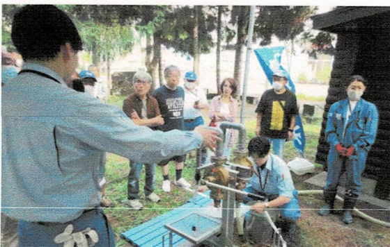
緊急貯水槽を説明をする札幌市水道局職員
